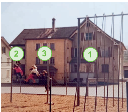
Abbildung 1: Altes Schulhaus Hemmerswil
